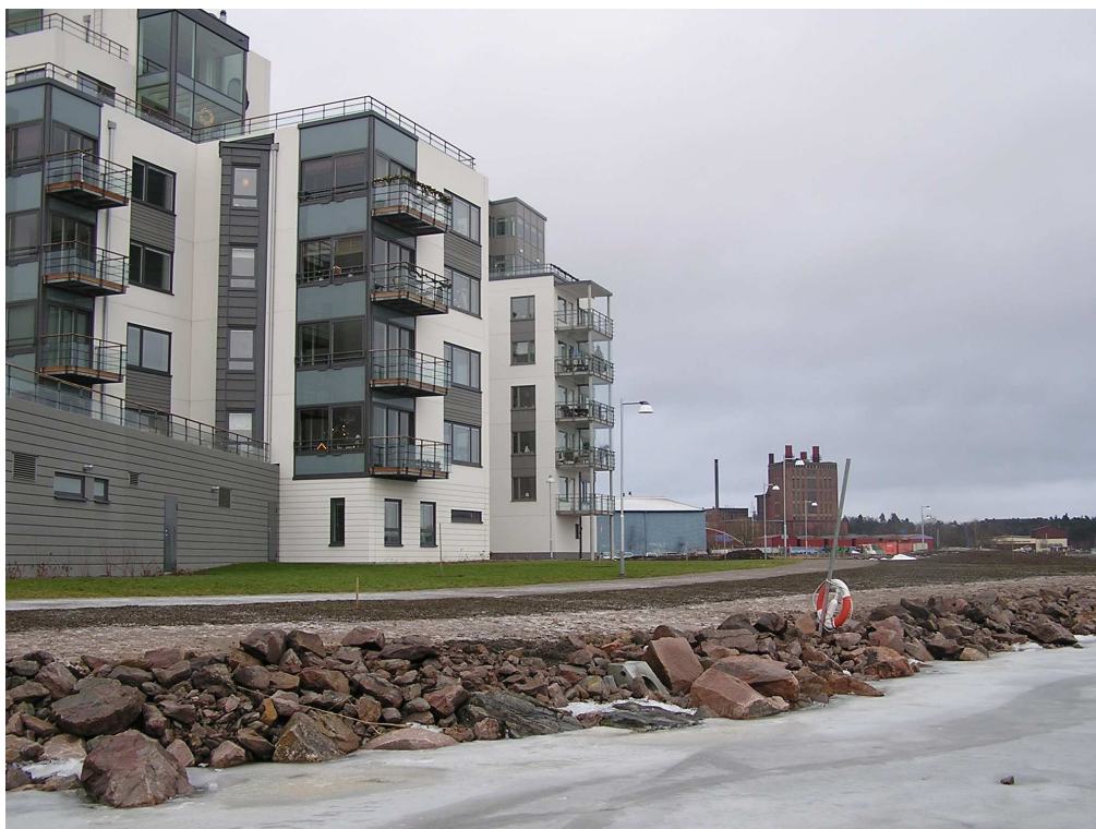
Figur 1.2. Ett nybyggt område på Lillåudden vid Mälarens strand i centrala Västerås är ett exempel på ett översvämningsskänsligt område. Bottenvåningarna innehåller här endast garage och tvättstugor. Foto: Torbjörn Olsson.
