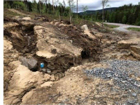
Figur 53. Erosion i skogsbilväg. Notera dunk med spolärvätska. Foto: Erik Eriksson, Trafikverket
